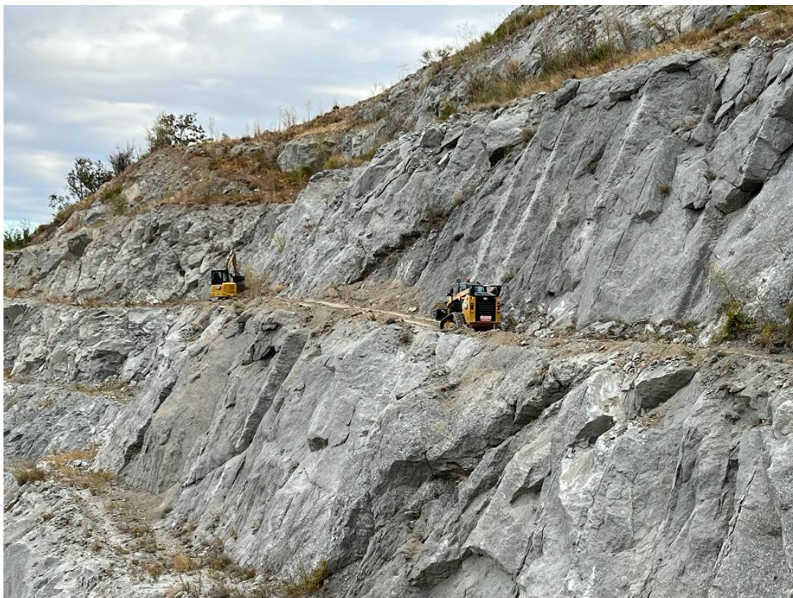
Figura 3-3 Operazioni di recupero dei gradoni esauriti (primavera 2023)
