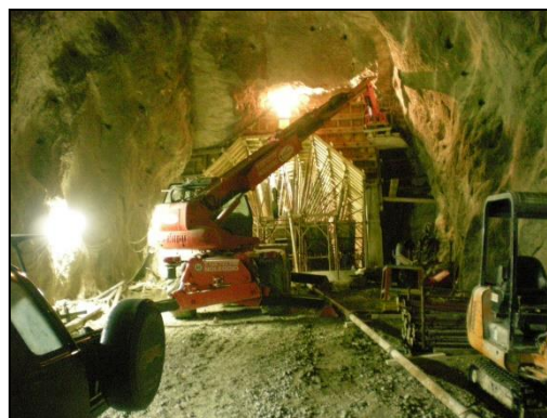
Figura 2-15 Fase di realizzazione della centinatura
