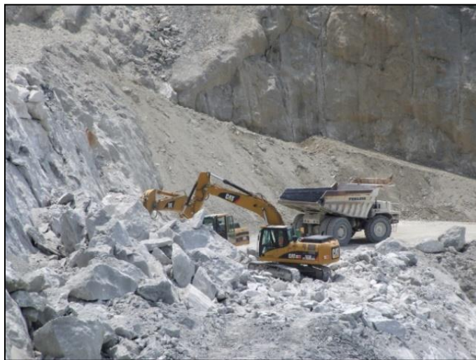
Figura 3-2 Operazioni di smarino
