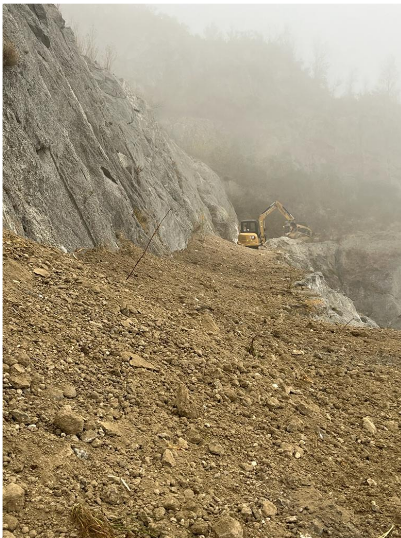
Figura 3-7 Stendimento del terreno vegetale sui gradoni
