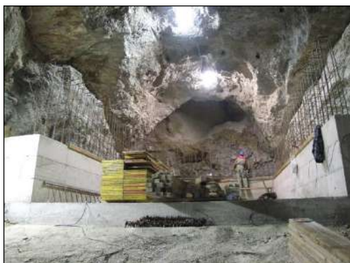
Foto 1: Fase di realizzazione della centinatura
