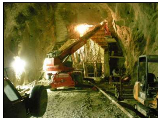
Foto 2: Fase di realizzazione della centinatura
