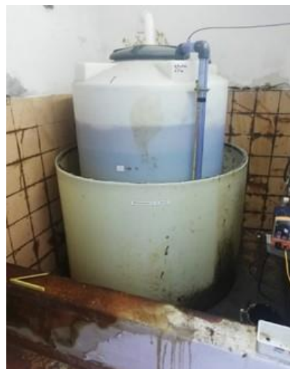
Figura 3.18 - Vasca di contenimento del permanganato
