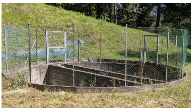
Figura 3.6 – Sedimentatore primario, recinzione e muretto di contenimento (stato attuale)
