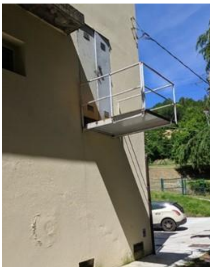
Figura 3.16 – Pianerottolo metallico da sostituire
