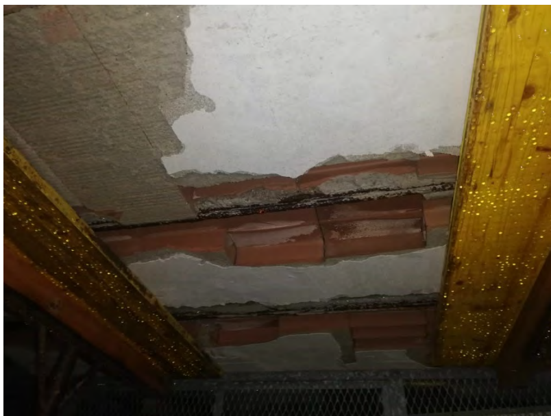
Fig.13 - Solaio da ricostruire (edificio di servizio)
