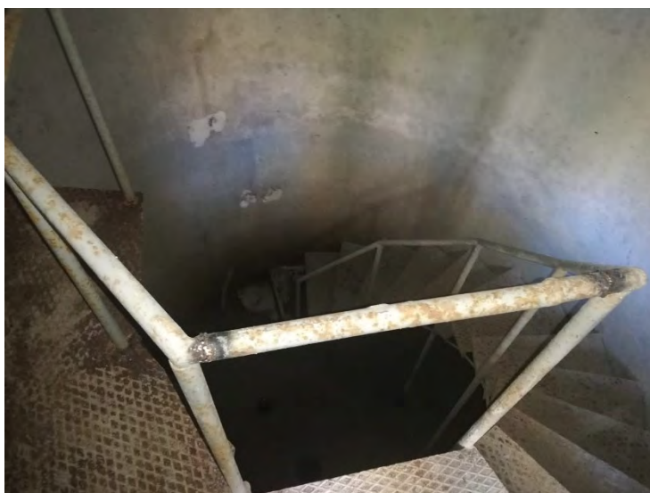
Fig. 15 – Scala interna al torrino, da sostituire
