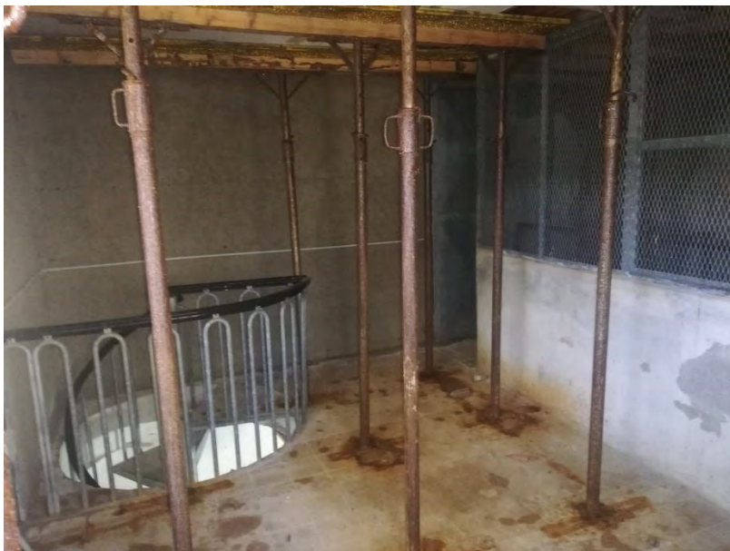
Fig.12 - Scala a chiocciola interna da rimuovere e parete divisoria vasca V6
