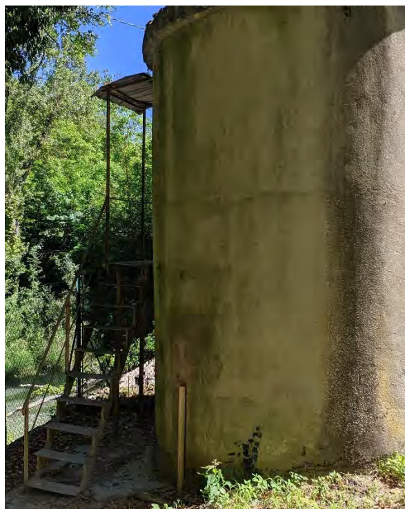
Fig. 14 –Tettoia da rimuovere e scala di accesso da sostituire
