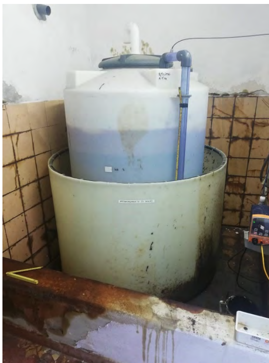
Fig.18 - Vasca di contenimento del permanganato
