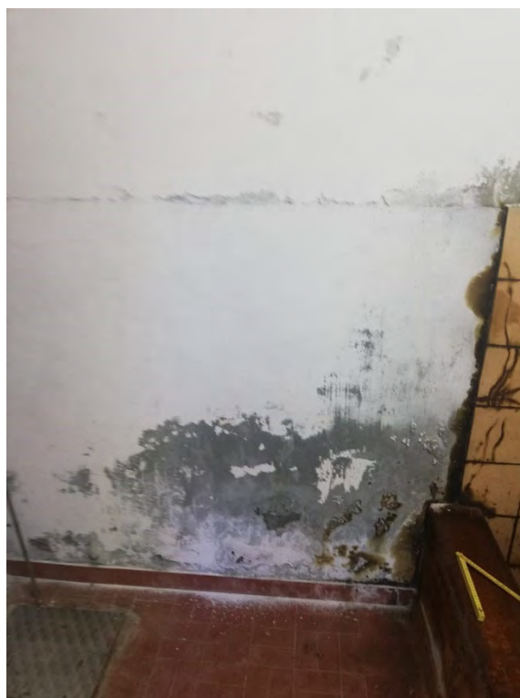
Fig.18 - Infiltrazione di permanganato di sodio
