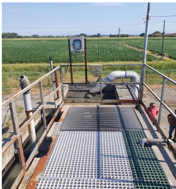
Vista della sezione del pozzetto di accumulo e canale dissabbiatura, disoleatura.
