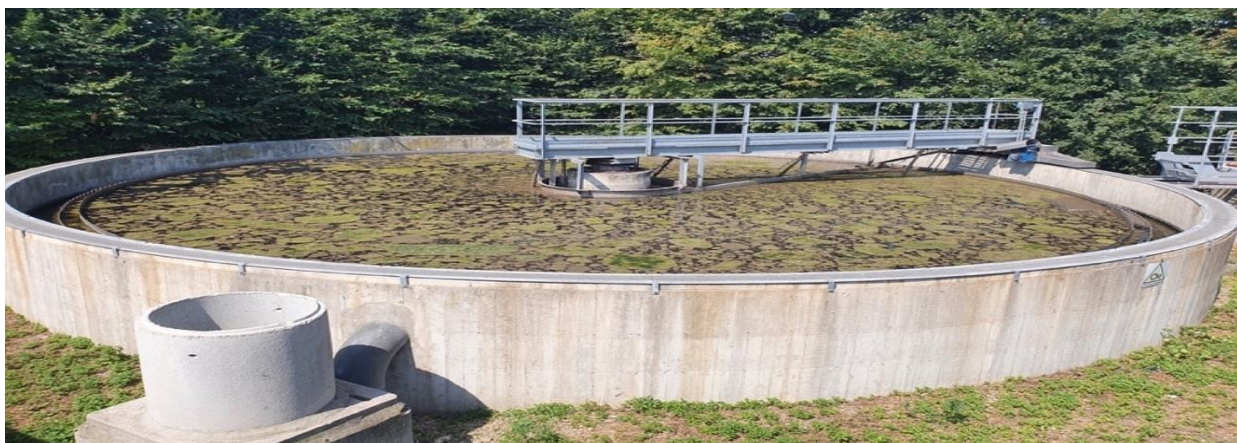
Vista della vasca circolare di Sedimentazione secondaria.
