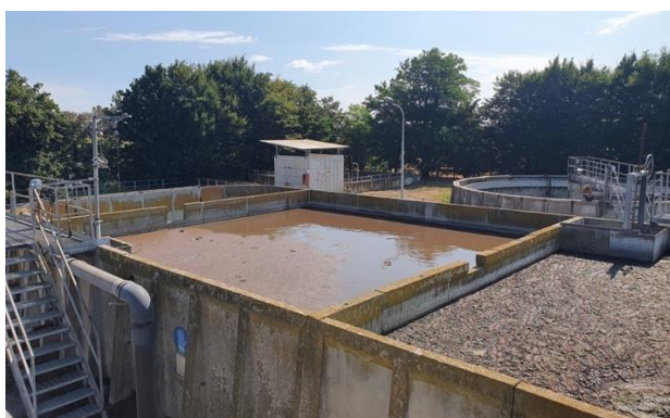
Vista della vasca rettangolare di nitrificazione e della vasca a Pioggia.
