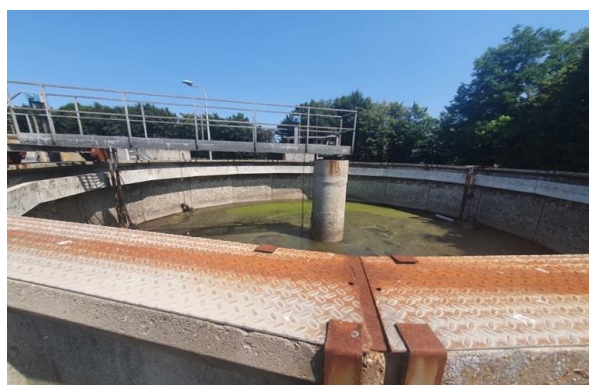
Vista della vasca rettangolare di nitrificazione e della vasca a Pioggia.
