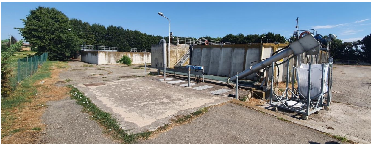
Vista della sezione dei pretrattamenti: sollevamento, grigliatura, pozzetti valvole e di esclusione impianto.
