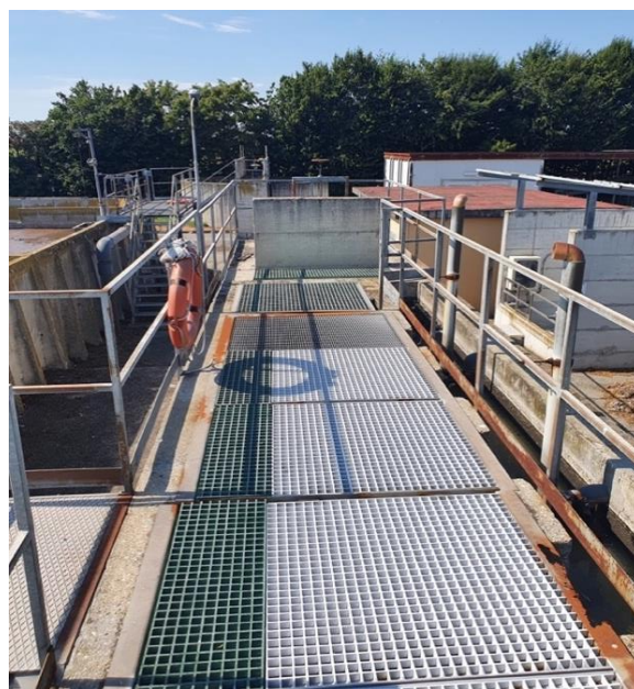
Vista della sezione del pozzetto di accumulo e canale dissabbiatura, disoleatura.
