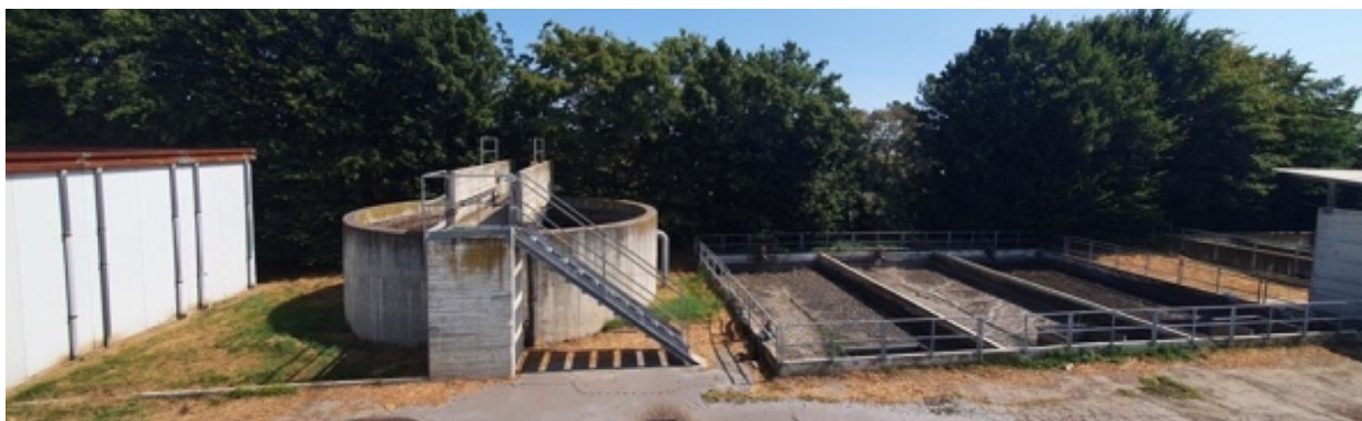
Vista dell'ispessitore e delle vasche dei letti di essiccamento
