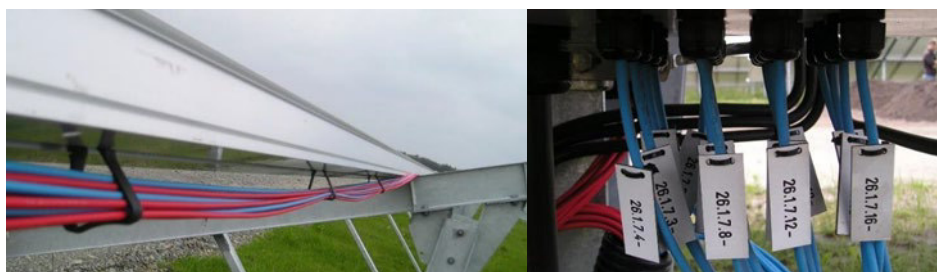
Figura 4: Conduttori DC (lato BT)
