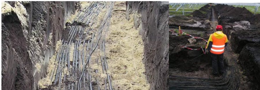
Figura 5: Conduttori CA (lato BT)
