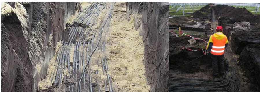
Figura 5: Conduttori CA (lato BT)
