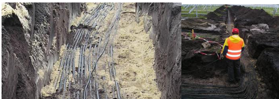
Figura 90: Conduttori AC (lato BT)
