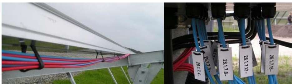
Figura 89: Conduttori DC (lato BT)
