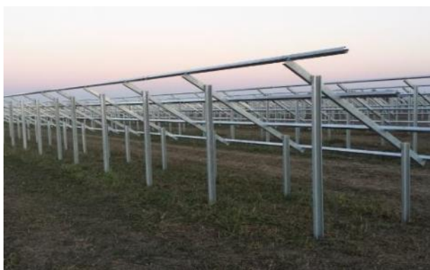
Esempio di posa delle strutture portanti.
