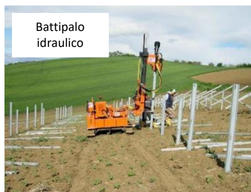
Esempio di posa delle strutture portanti.
