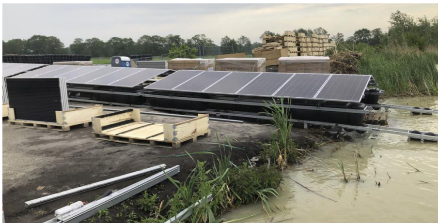
Foto 20 – modulo galleggiante assemblato e pronto per essere spostato in acqua utilizzando il binario/scivolo dalla riva.
