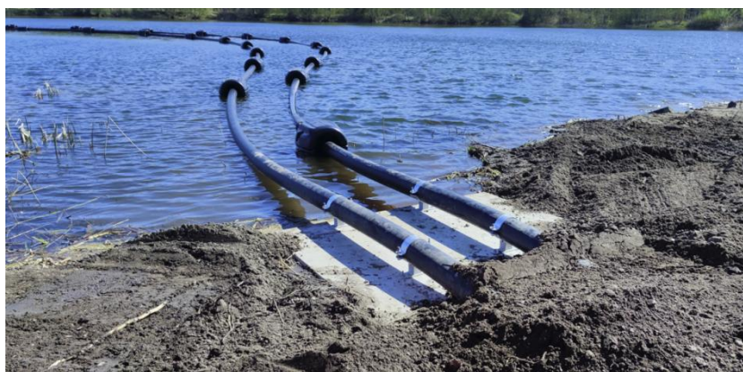
Foto 18 – dettaglio della piattaforma in cls di dimensioni 2x2 metri prefabbricata per l'ancoraggio dei cavi alla sponda. I cavi saranno poi posti in cavidotti interrati fino alla cabina di consegna.
