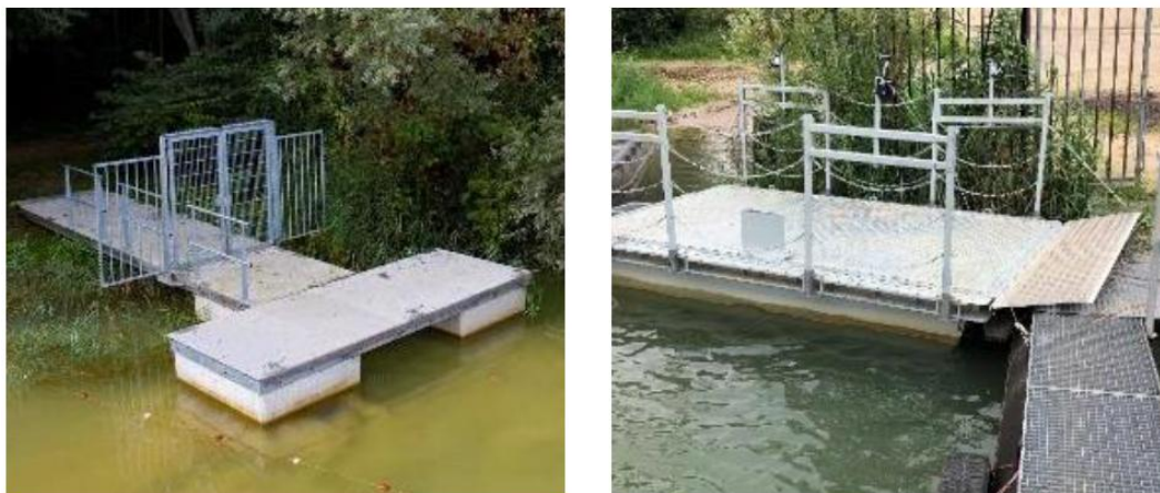
Fig. 45 – esempi di pontili galleggianti e passerelle per l'accesso all'impianto. Nell'impianto di Cervia i moduli galleggianti saranno raggiungibili da terra con l'utilizzo di un piccolo battello.
