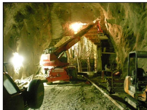
Foto 2: Fase di realizzazione della centinatura
