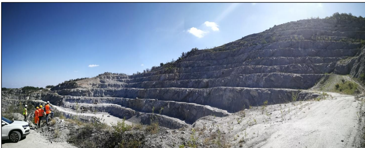
Foto 5: Progressione della gradonatura in linea col progetto approvato
