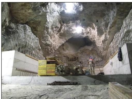
Foto 1: Fase di realizzazione della centinatura
