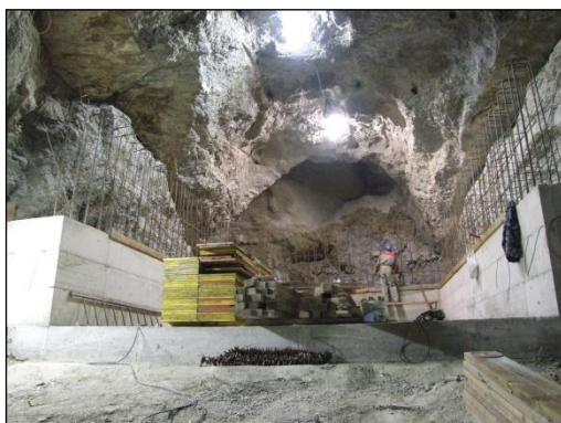
Foto 1: Fase di realizzazione della centinatura
