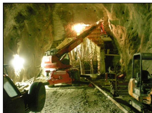
Foto 2: Fase di realizzazione della centinatura
