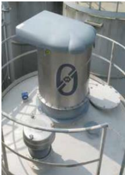
Figura 7 – Esempio della tipologia di filtro che si intende installare sullo sfiato dei silos
