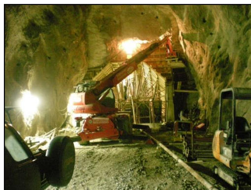
Foto 2: Fase di realizzazione della centinatura
