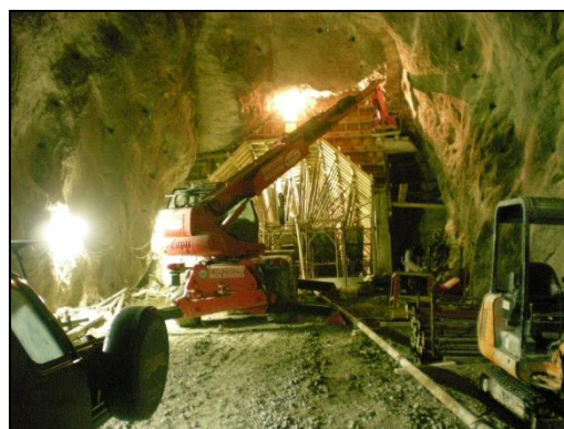
Foto 2: Fase di realizzazione della centinatura
