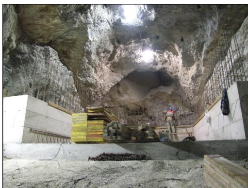
Foto 1: Fase di realizzazione della centinatura
