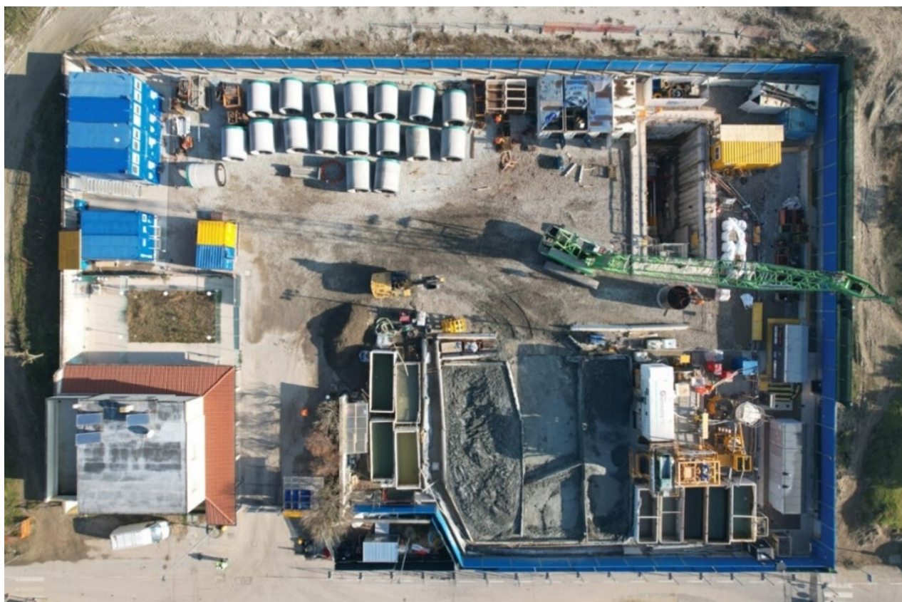
Figura 5 – Vista dall'alto dell'area Ex Sarom nel 2023, con le barriere perimetrali visibili in blu.
