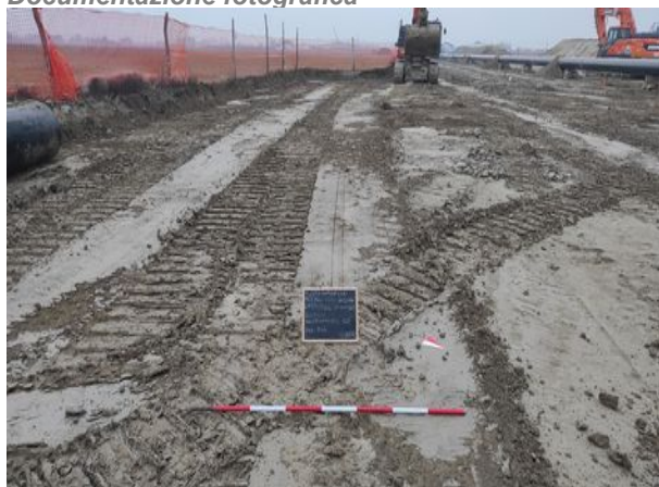
Foto f010 (presa da NE)
