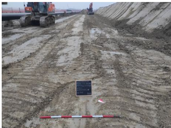
Foto f011 (presa da NE)
