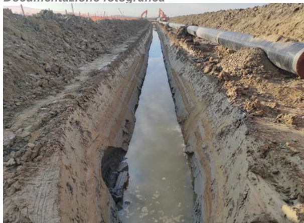
Foto f014. Trincea di scavo (presa da NE)
