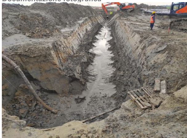
Foto f017. Trincea di scavo (presa da NE)
