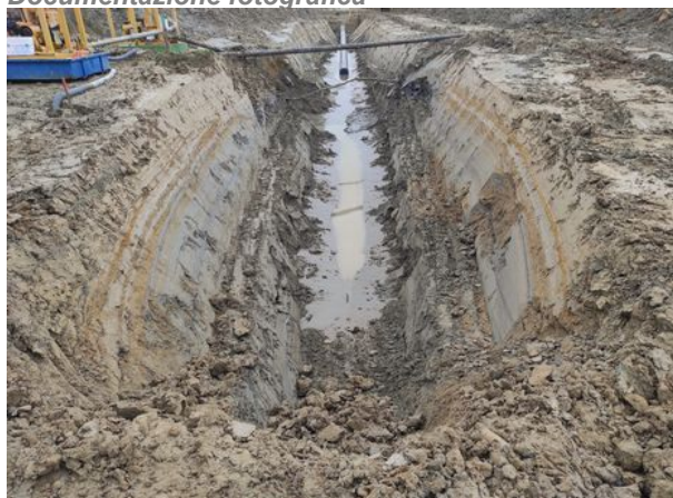
Foto f018. Trincea di scavo (presa da NE)
