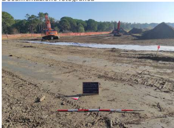
Foto f009 (presa da W)
