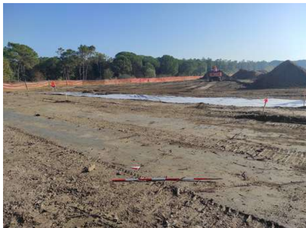
Foto f009 (presa da w)
