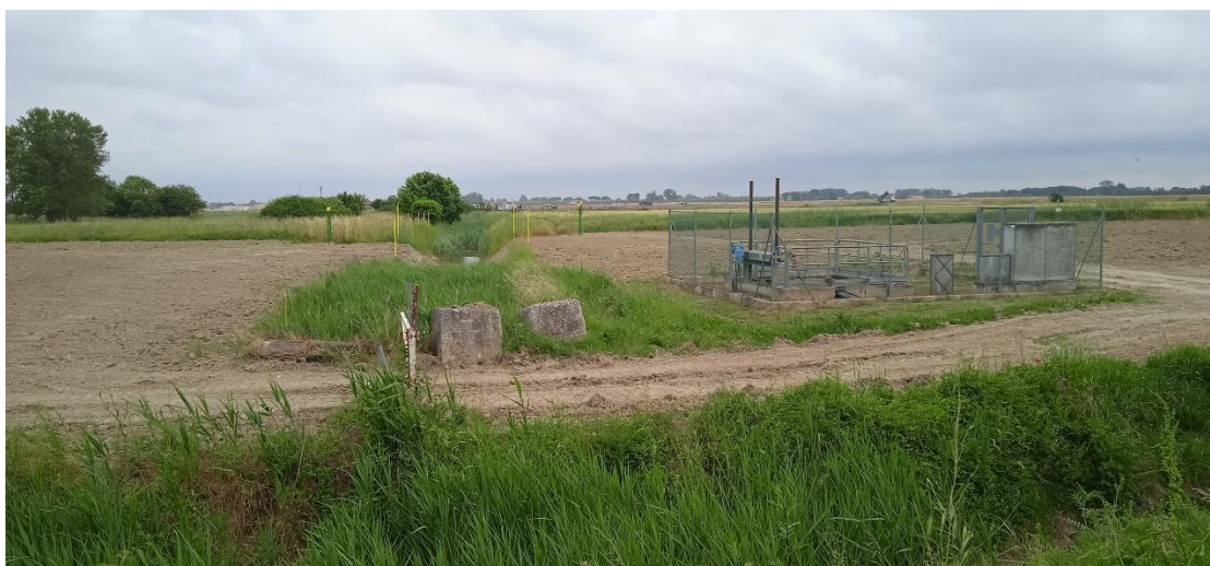
Figure 4-7: Dall'alto in basso: cantiere aperto presso la stazione di rilevamento a marzo; stazione di rilevamento a maggio 2024.
