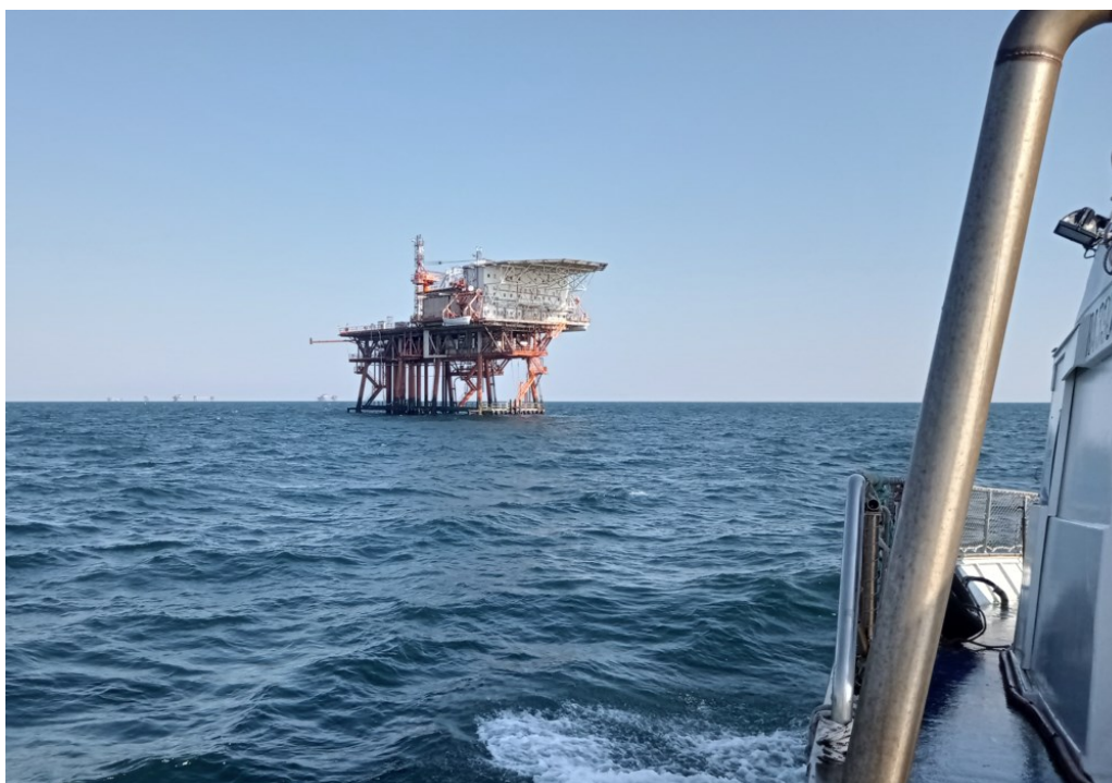
Figura 2.7 Piattaforma Garibaldi B
