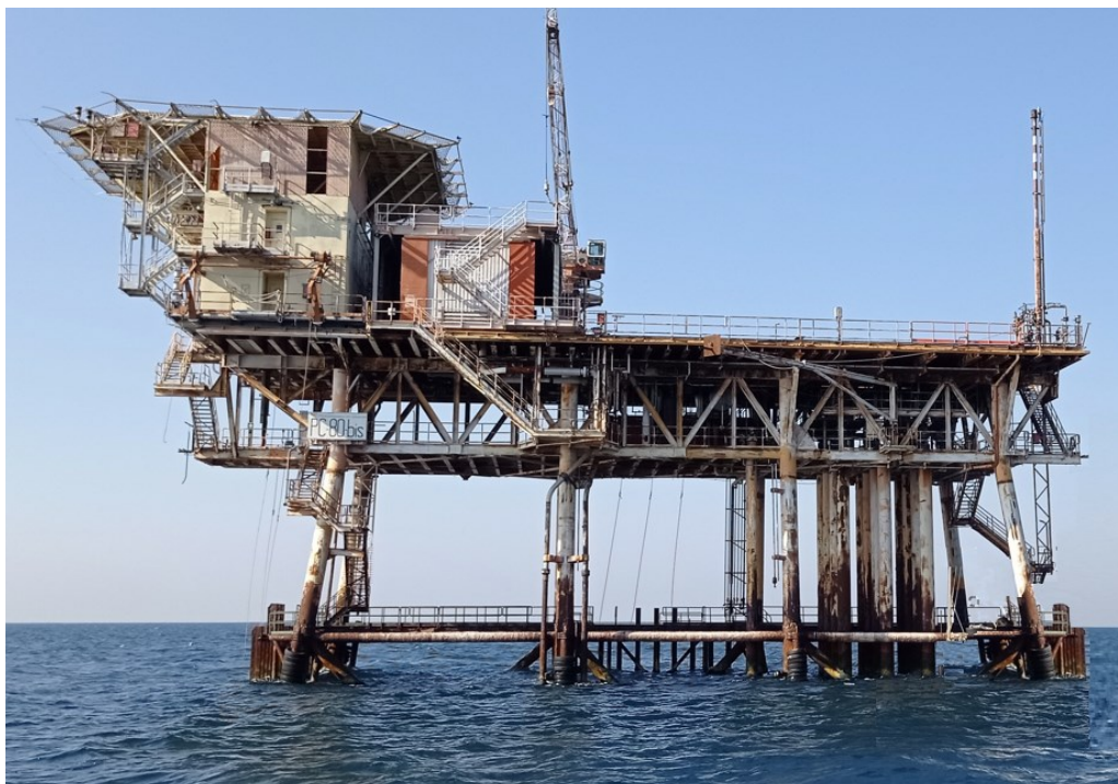
Figura 2.4 Piattaforma Porto Corsini 80 bis
