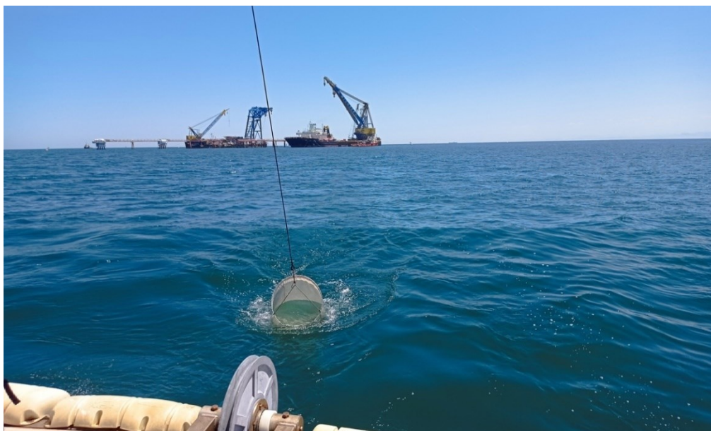
Figura 3-2 Fase di recupero retino in prossimità dell'area di cantiere FSRU
