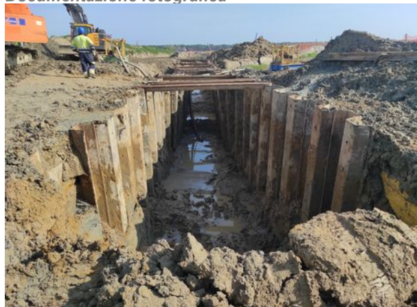
Foto f020. Trincea di scavo (presa da SO)
