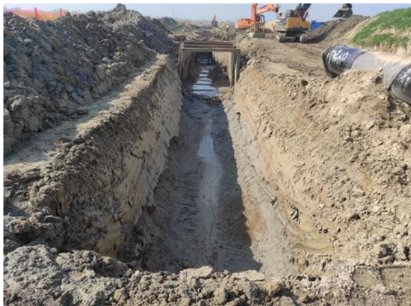
Foto f021. Trincea di scavo (presa da NE)
