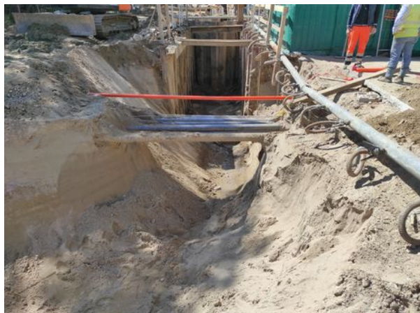
Foto f025. Via C. Colombo: scavo di linea (presa da ENE)
