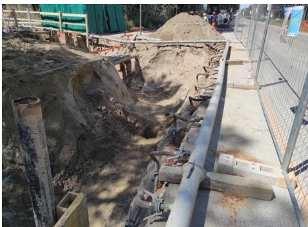
Foto f026. Via C. Colombo: scavo di linea (presa da SSE)
