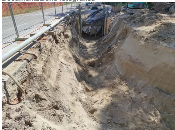
Foto f024. Via C. Colombo: scavo di linea (presa da NNW)
