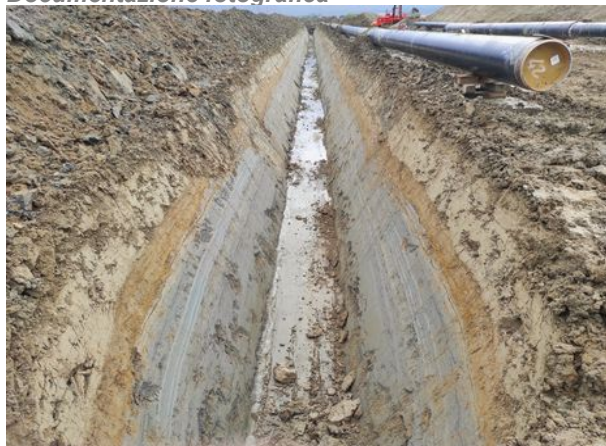
Foto f019. Trincea di scavo (presa da NE)
