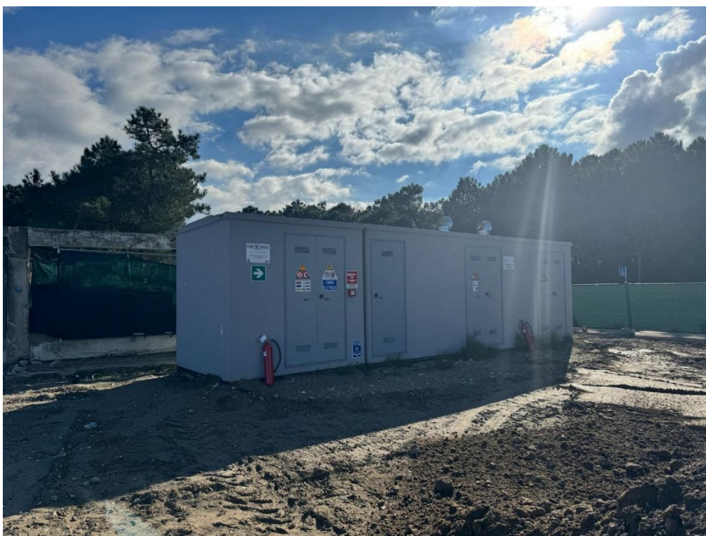
Figura 3.1 Cabina MT – Ante operam – Foto n. 1
