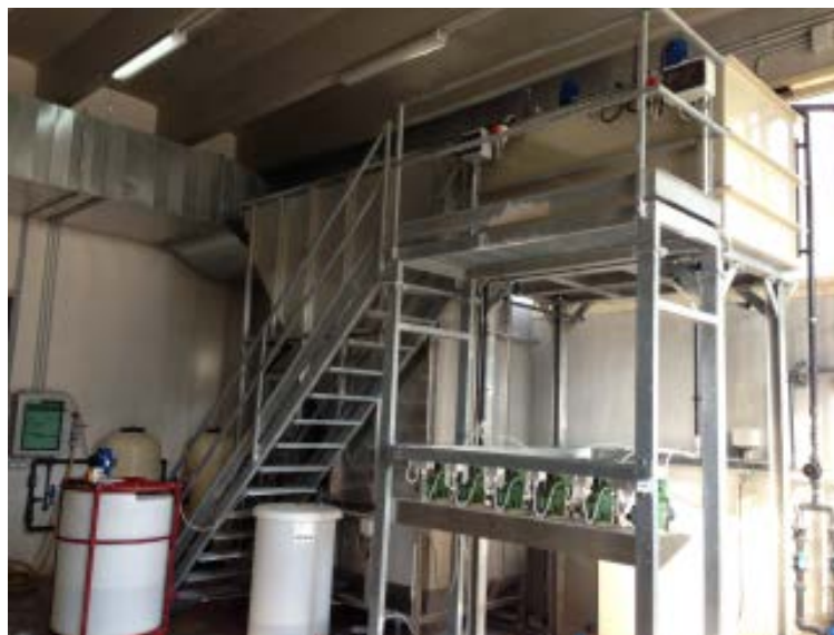
▪ Figura 6 – Decantatore
