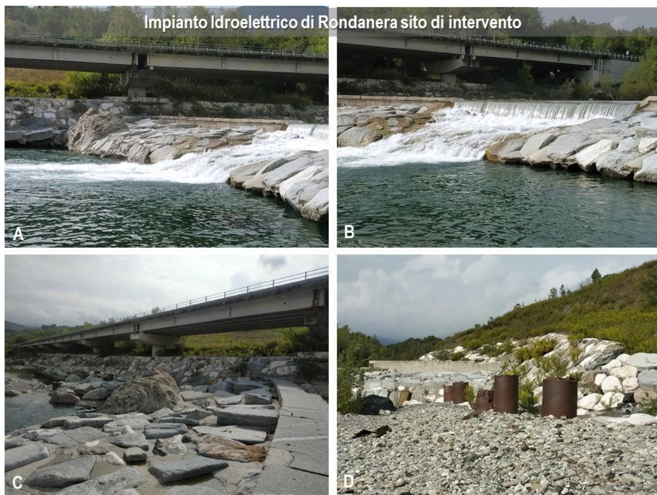
Figura 12: immagini relative alla sponda idrografica destra. In A lato destro della traversa (realizzata con massi intasati) e la sponda fluviale completamente artificializzata sovrastata dalla SS 45. IN B: vista della porzione centrale della gaveta, sulla quale verrà inserita la struttura di regimazione. In C dettaglio della traversa che presenta al piede una platea di massi intasati a consolidarne la base e a contrastare l'erosione. In D dettaglio del lato sinistro della traversa con presenza dei resti di piloni metallici.
