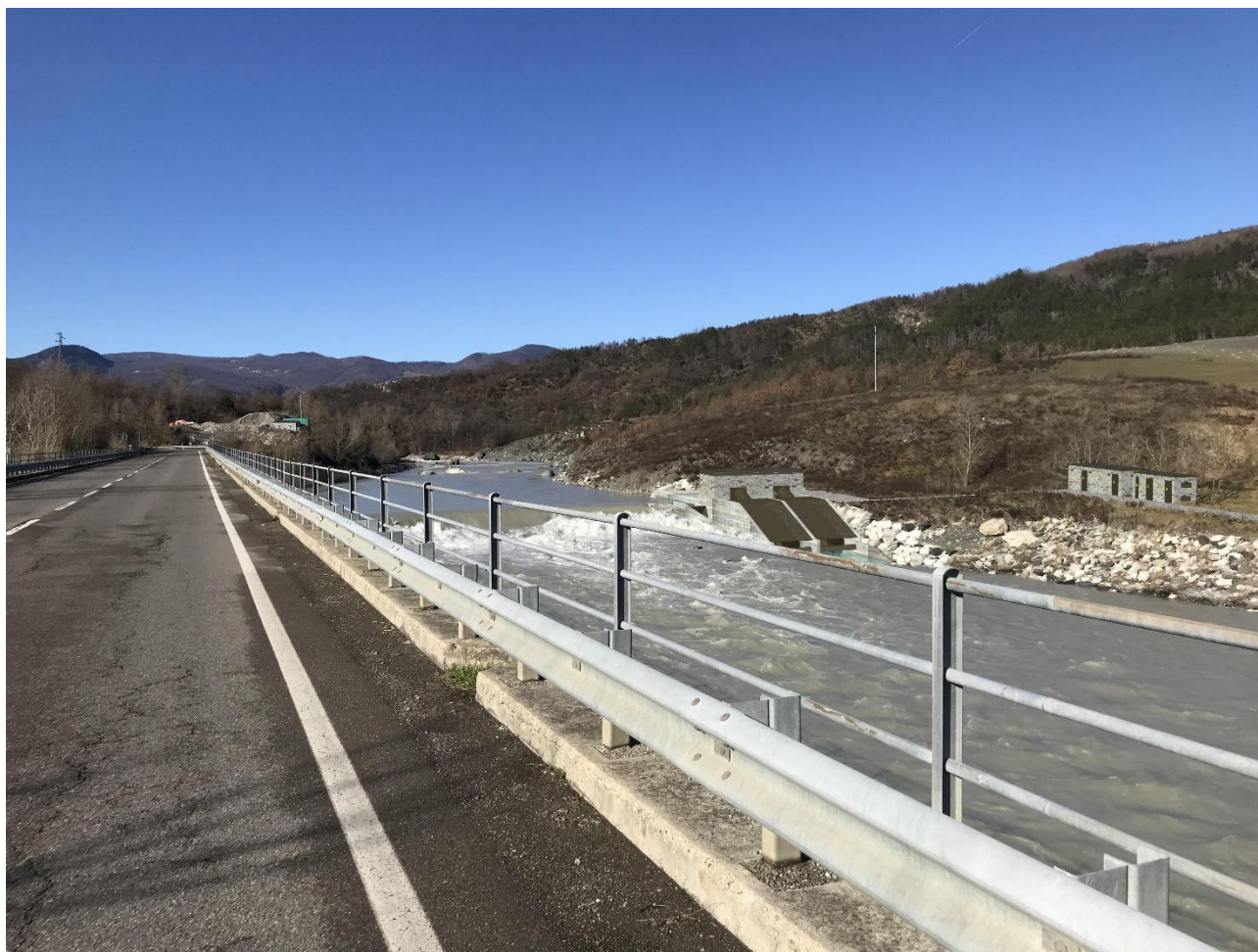
Figura 24 – Foto 1 stato di progetto, variante 2. Il fotoinserimento riporta una soluzione progettuale in cui si prevede la copertura delle coclee tramite apposito grigliato (qui visibile di colore RAL 6014). Qualora richiesto, si può prevedere anche la copertura delle coclee mediante pannelli rivestiti da terreno (questa soluzione al momento è stata scartata in quanto eventuali piene andrebbero ad erodere il terreno di riporto).
