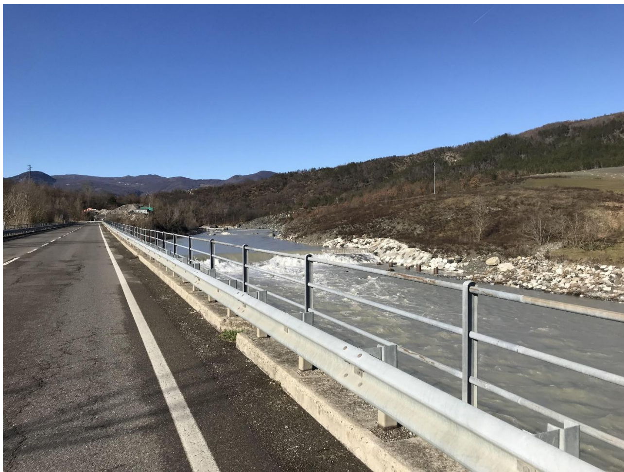
Figura 21 – Foto 1 stato di fatto. Foto scattata dalla SS45 verso la sponda sinistra del Fiume Trebbia. Dalla visuale scelta si nota la presenza della briglia (seppur sormontata dall'acqua) e delle scogliere di protezione delle sponde. Si nota anche la presenza della linea elettrica su pali.
