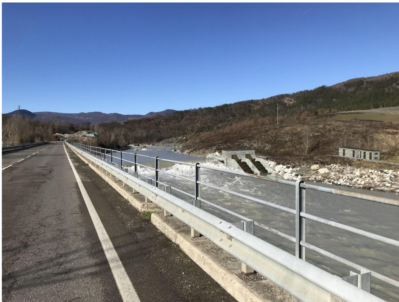
Figura 22 – Foto 1 stato di progetto. Il fotoinserimento riporta le condizioni di progetto considerando le sole strutture (no piantumazione e mascheramenti). Nei pressi della briglia è previsto l'impianto idroelettrico mentre sul versante si nota la presenza delle cabine (volume tecnico di controllo dell'impianto e cabina elettrica). Le cabine sono delocalizzate dall'impianto per proteggerle da eventuali alluvioni. Tutte le strutture saranno raggiungibili tramite strada sterrata di nuova realizzazione.
