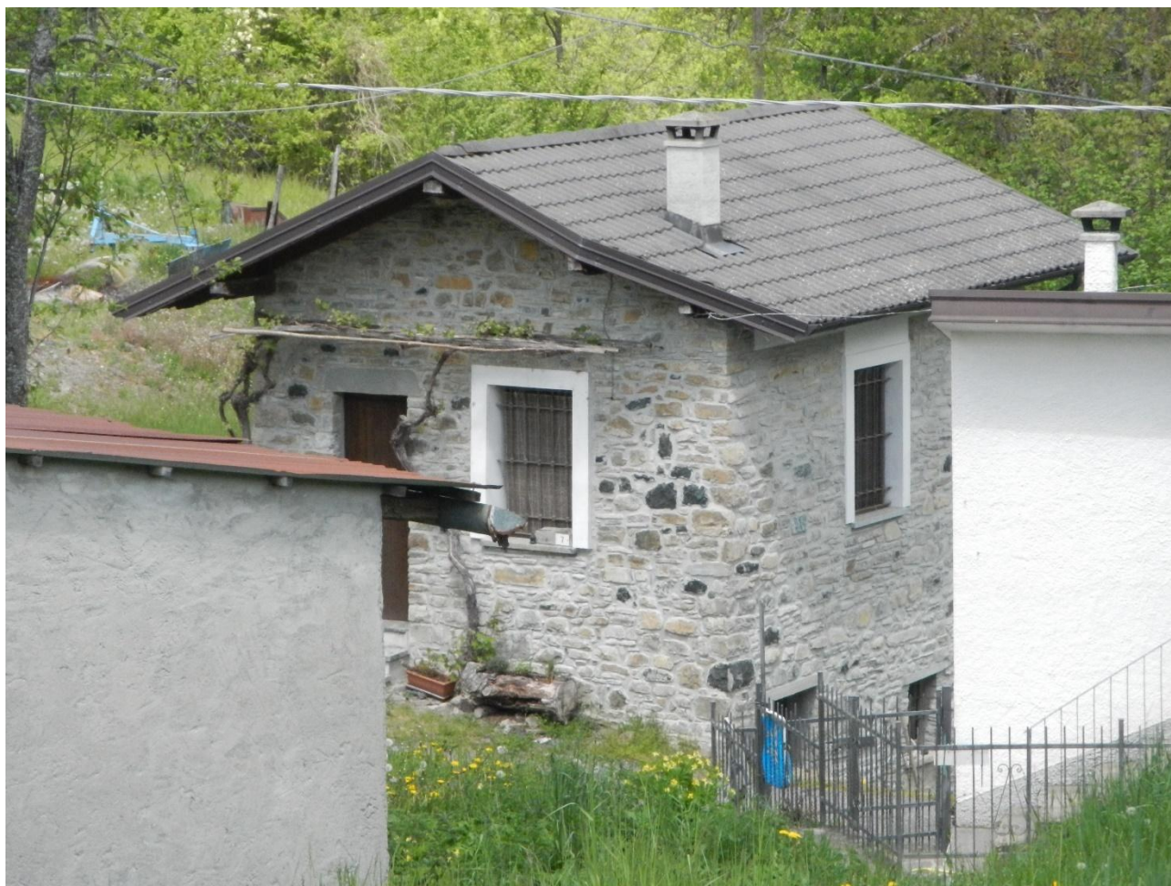
Figura 30 – Esempio di edificio con muri in pietra locale (la pietra è costituita da elementi eterogenei ed eterometrici di forma abbastanza irregolare, rappresentati da calcari, calcari marnosi, arenarie e ofioliti). I muri in elevazione della centrale idroelettrica e delle cabine si prevede di rivestirli con pietra locale come quella qui visibile.
