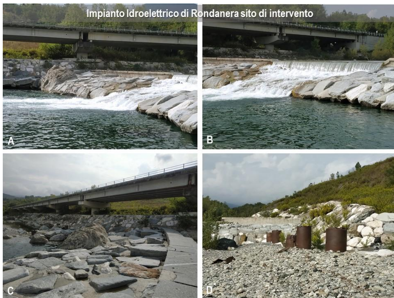
Figura 22: immagini relative alla sponda idrografica destra. In A lato destro della traversa (realizzata con massi intasati) e la sponda fluviale completamente artificializzata sovrastata dalla SS 45. IN B: vista della porzione centrale della gaveta, sulla quale verrà inserita la struttura di regimazione. In C dettaglio della traversa che presenta al piede una platea di massi intasati a consolidarne la base e a contrastare l'erosione. In D dettaglio del lato sinistro della traversa con presenza dei resti di piloni metallici.
