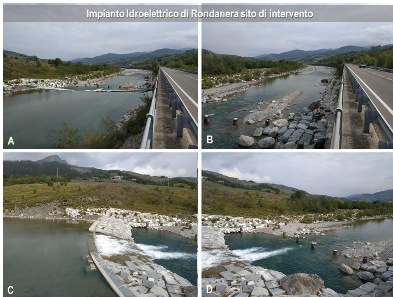
Figura 23: viste della sponda idrografica sinistra in corrispondenza del tratto di inserimento dell'impianto. In A panoramica del tratto di inserimento delle opere, il canale di adduzione si aprirà accanto alla traversa esistente; in B tratto di sponda immediatamente a valle del punto in cui verranno restituite le acque. In C la spalla della traversa esistente dove verrà realizzato il corpo centrale dell'impianto. In D, porzione in cui si svilupperà la porzione finale del canale di restituzione.
