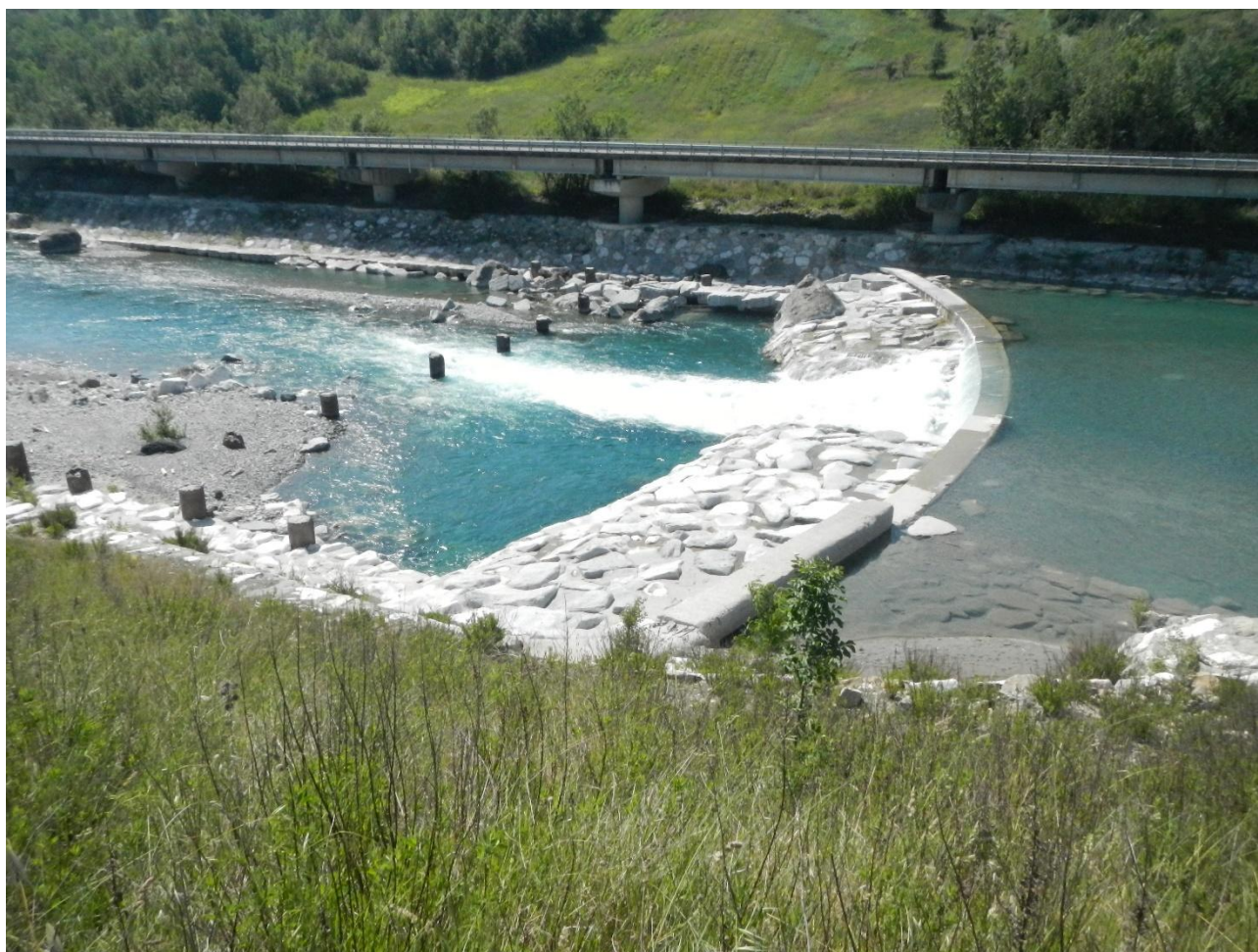
Figura 15 – Aspetto della briglia in condizioni di magra: si noti il passaggio della vena liquida solo dalla gaveta centrale. Da questa immagine si può notare la presenza di una platea in massi anche a monte della briglia (in sinistra), il pennello antiersivo (estrema dx nell'immagine), la scogliera continua e le strutture della SS45.
