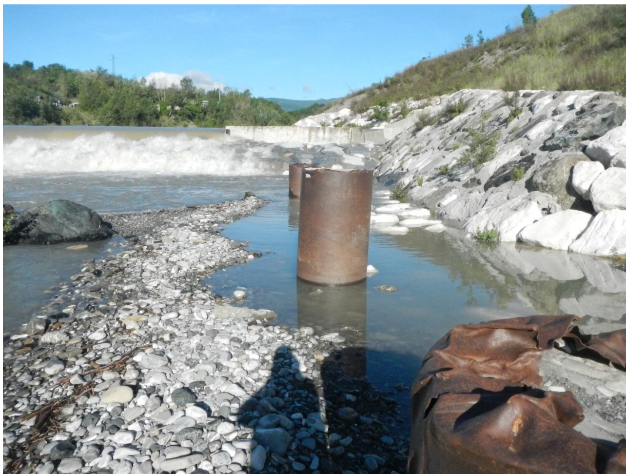
Figura 14 – Foto della briglia (ala sinistra) ripresa da valle. Si nota la presenza della briglia in ca (la gaveta è sommersa), delle imponenti scogliere e platee, e dei pali di grande diametro. Si riesce a notare anche la composizione media granulometrica del materiale d'alveo, compreso (estrema sx nell'immagine) la presenza di un blocco ofiolitico.
