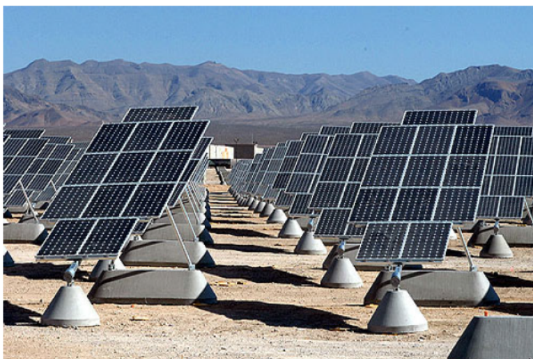
Figura 6: impianto fotovoltaico ad inseguitore monoassiale
