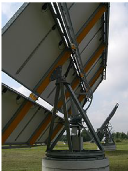
Figura 12: inseguitore a due gradi di libertà
