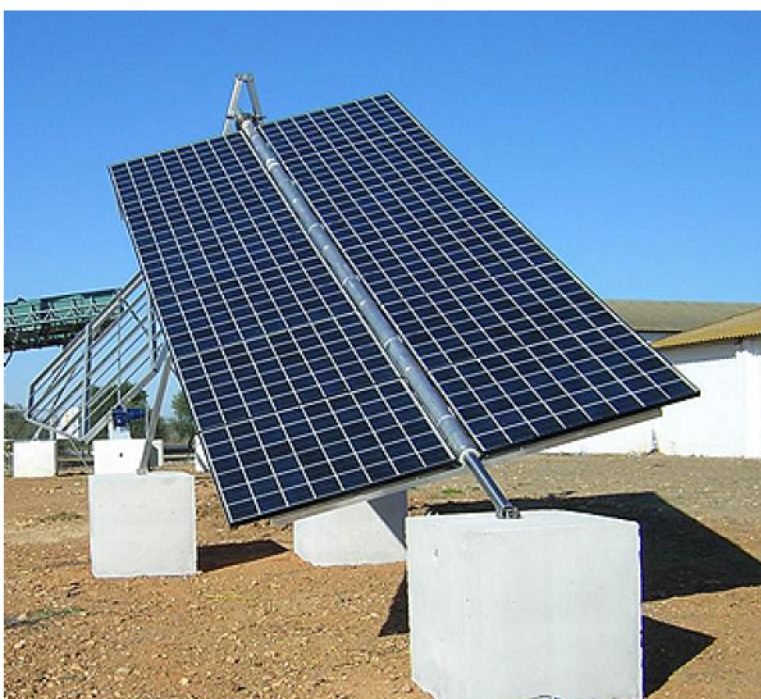
Figura 11: inseguitore ad asse polare
