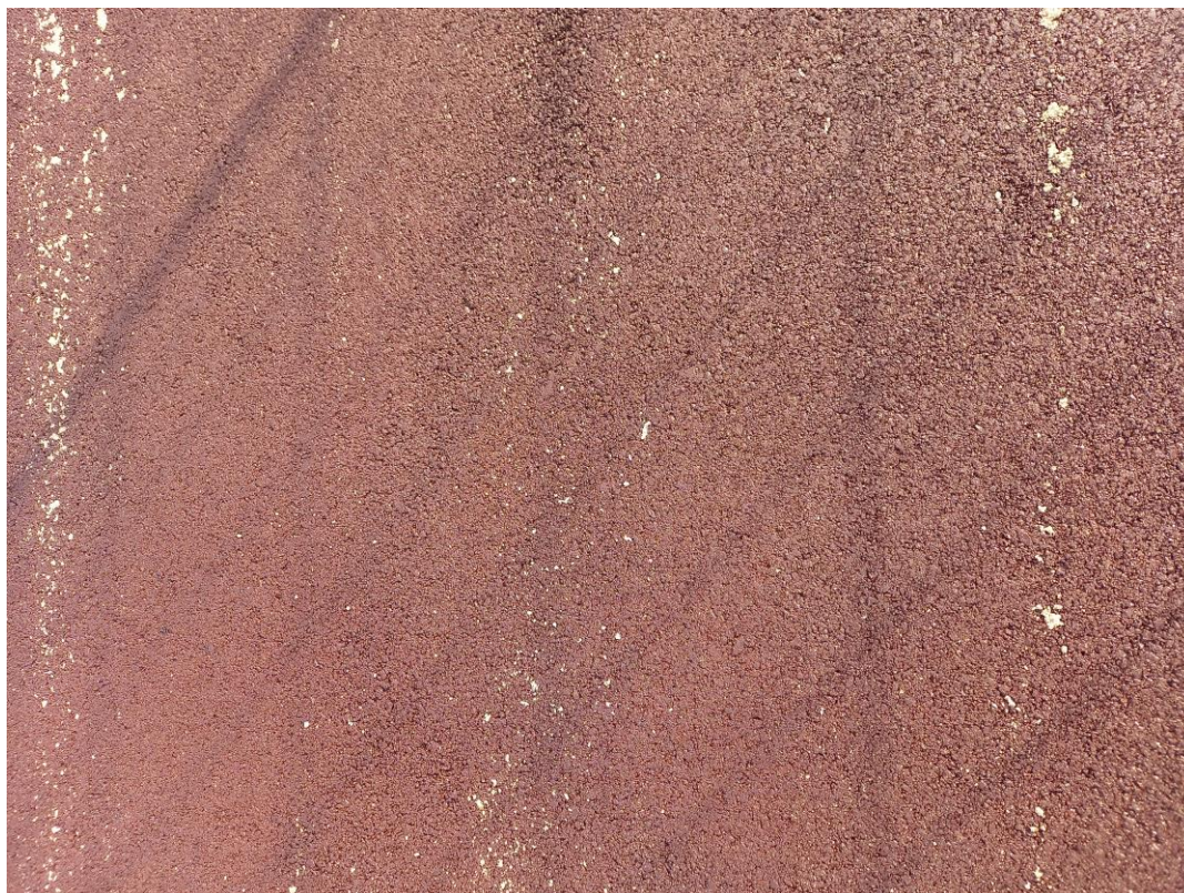
Figura 5 - Asfalto color ocra subito dopo la compattazione
