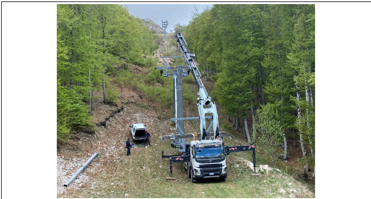
Figura 31 Smontaggio delle testate dei sostegni di una seggiovia
