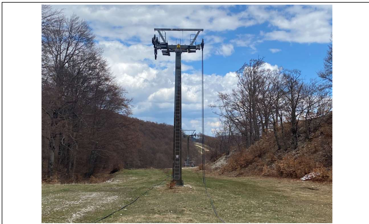
Figura 30 Smontaggio fune portante traente su seggiovia triposto
