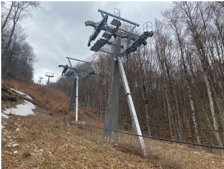
Figura 29 Smontaggio fune portante traente su seggiovia triposto
