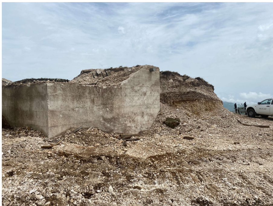
Figura 35 Manufatto di fondazione da demolire con relativi tirafondi (stazione rinvio seggiovia)
