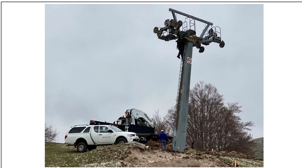
Figura 32 Smontaggio delle testate dei sostegni di una seggiovia
