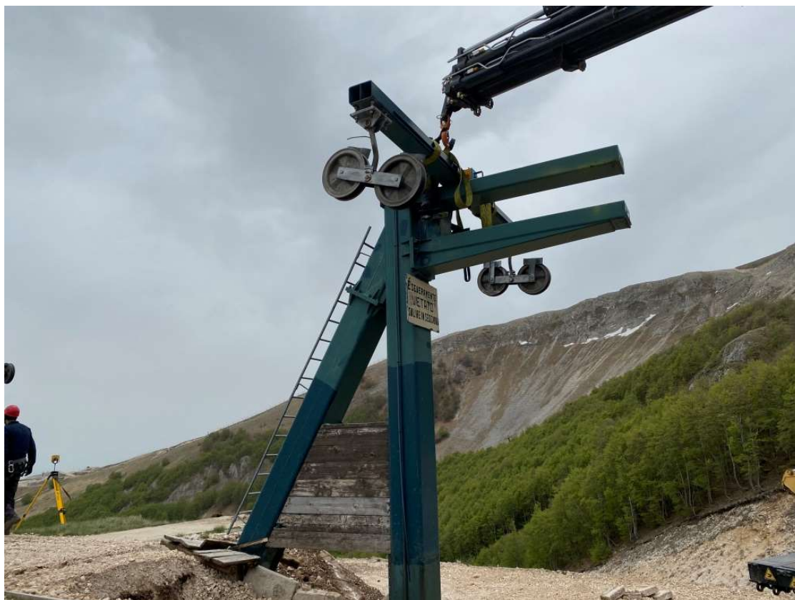
Figura 33 Smontaggio stazione rinvio seggiovia
