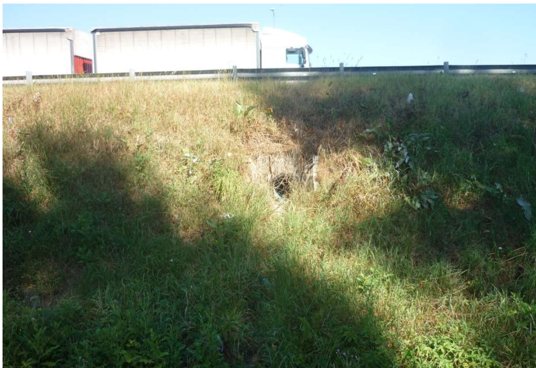
Figura 4-9: Esempio di manufatto di sbocco tubazione trasversale di convogliamento acque di piattaforma A14.
