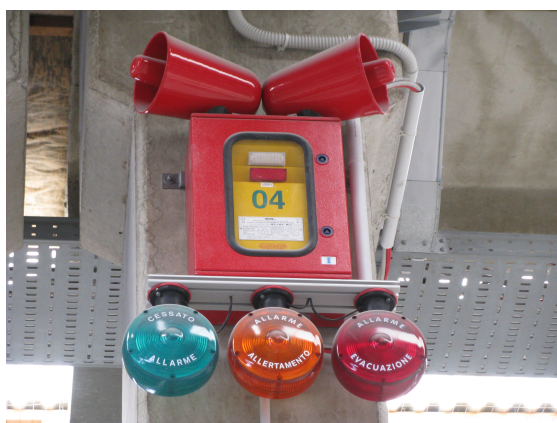
Fig.2: Sirena con lampada gialla di ALLERTAMENTO, rossa di EVACUAZIONE e verde di CESSATO ALLARME
