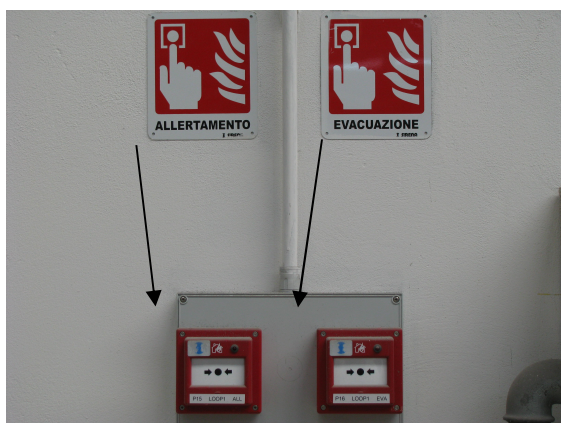
Fig.1:Pulsanti di ALLERTAMENTO e di EVACUAZIONE
