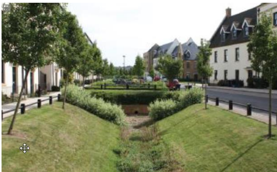
Figura 40: esempio di canale vegetato asciutto
