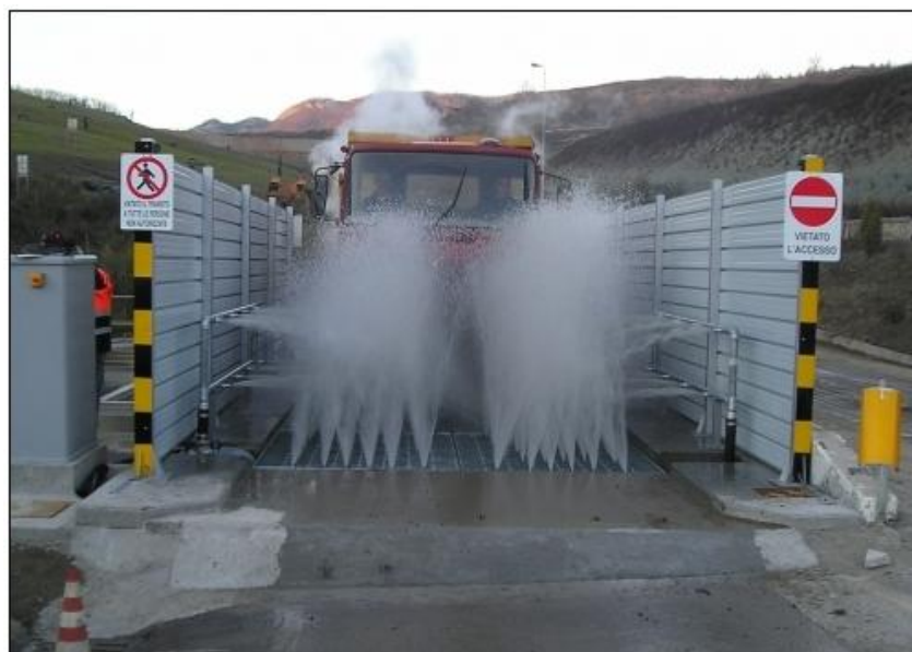
Figura 23 – Impianto lavaggio ruote
