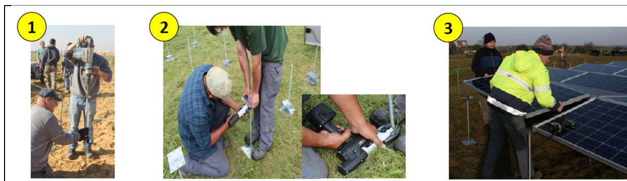
Figura 10 – Montaggio dei pannelli fotovoltaici
