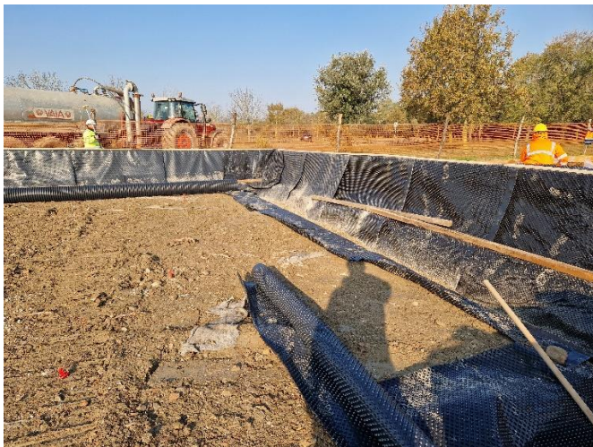
Figura 4-9 Esempio fasi realizzative preparazione dell'area di deposito del materiale di scavo microtunnel: a sinistra, fase prima del getto soletta con predisposizione HDPE per impermeabilizzazione della futura canaletta di raccolta e convogliamento acque; a destra, riempimento con materiale drenante attorno al tubo drenante
