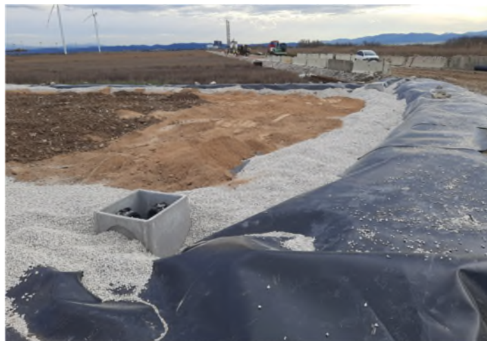
Figura 17 – Esempio di fasi realizzative di preparazione dell'area di deposito del materiale di scavo microtunnel: a sinistra, posa dei tubi drenanti di raccolta e convogliamento acque; a destra, posa pozzetti e riempimento con materiale drenante attorno al tubo drenante
