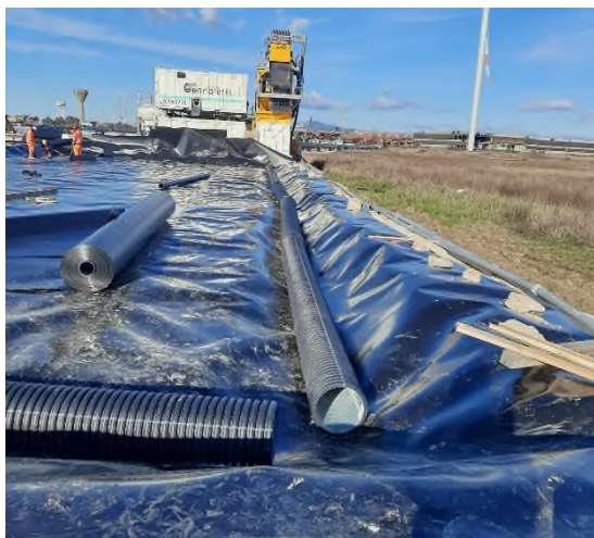
Figura 17 – Esempio di fasi realizzative di preparazione dell'area di deposito del materiale di scavo microtunnel: a sinistra, posa dei tubi drenanti di raccolta e convogliamento acque; a destra, posa pozzetti e riempimento con materiale drenante attorno al tubo drenante
