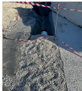
Figura 11 – Esempio di fasi realizzative di preparazione dell'area di deposito del materiale di scavo microtunnel: a sinistra, fase prima del getto soletta con predisposizione HDPE per impermeabilizzazione della futura canaletta di raccolta e convogliamento acque; a destra, riempimento con materiale drenante attorno al tubo drenante
