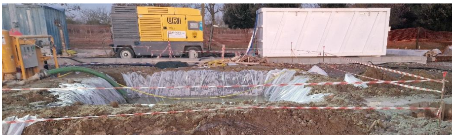
Figura 5-2 Esempio di punto di raccolta intermedio del refluo jet grouting
