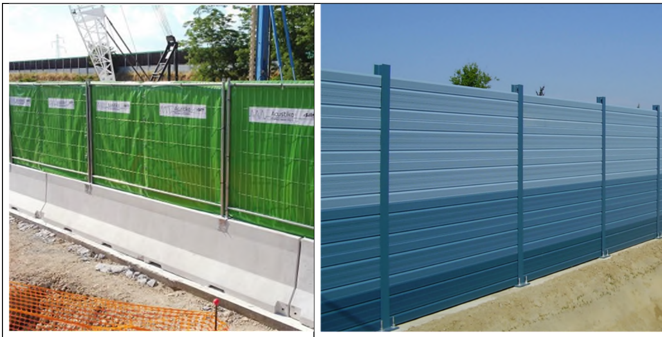
Figura 9 – Esempio di installazione di pannello fonoassorbente con involucro flessibile esterno (sx) e con struttura rigida (dx)
