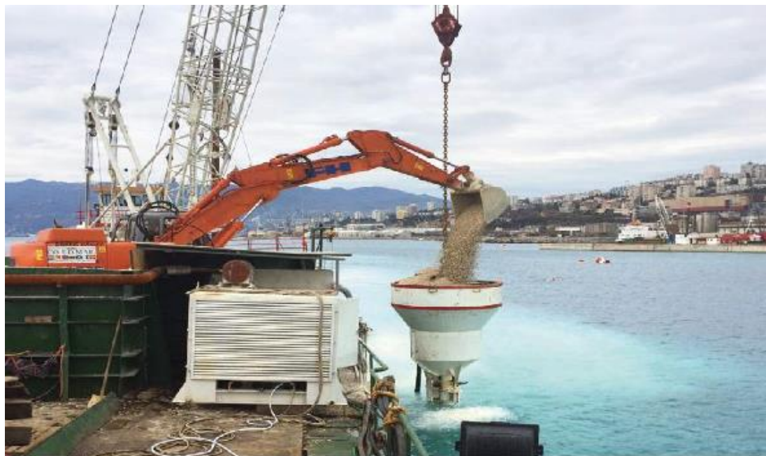
Figura 1-11 Immagine di imbarcazione utilizzata per trattamento di vibro-sostituzione del fondale
