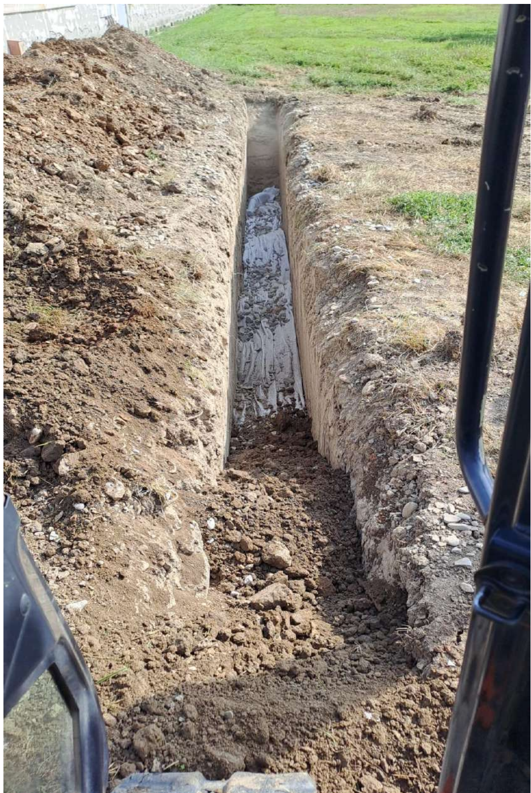
Foto della condotta di sub irrigazione posata dopo il pozzetto o di cacciata.
