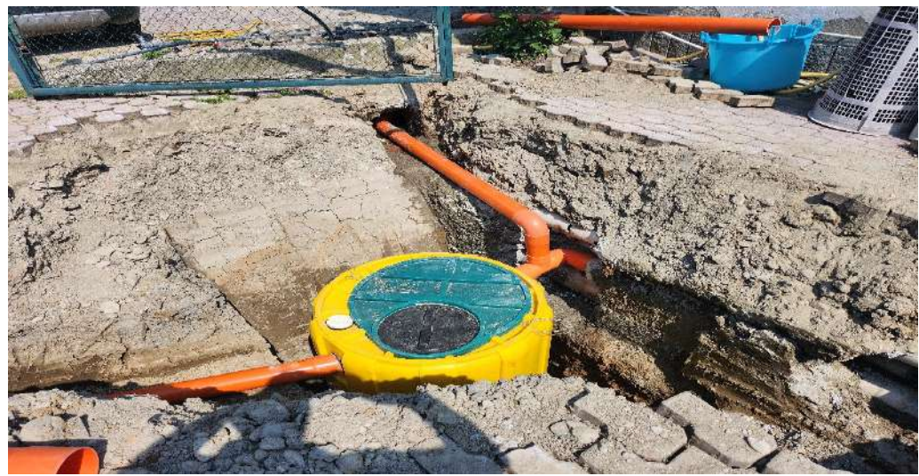
Foto della fossa x 5 AE con pozzetti d'ispezione, pozzetti o a cacciata e collegamento con biologica esistente dell'abitazione
