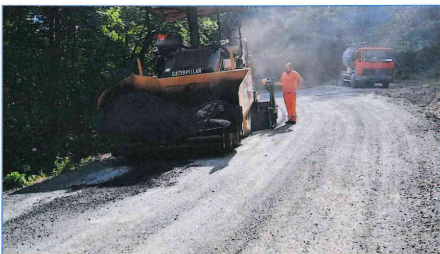
Foto 12 – Ripristino manto stradale con mezzi d'opera in azione
