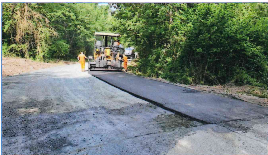
Foto 11 – Ripristino manto stradale con mezzi d'opera in azione
