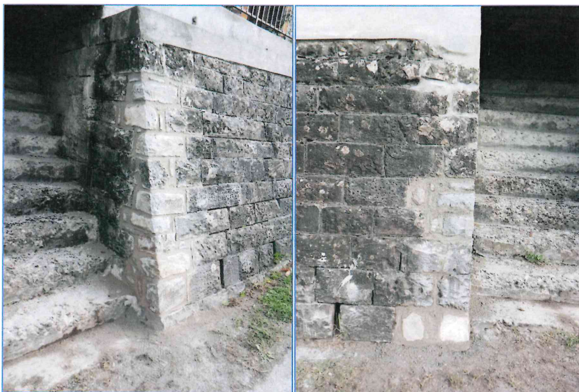
Foto 22 – Condizioni murette a lato dell'infrastruttura viaria dopo la sistemazione
