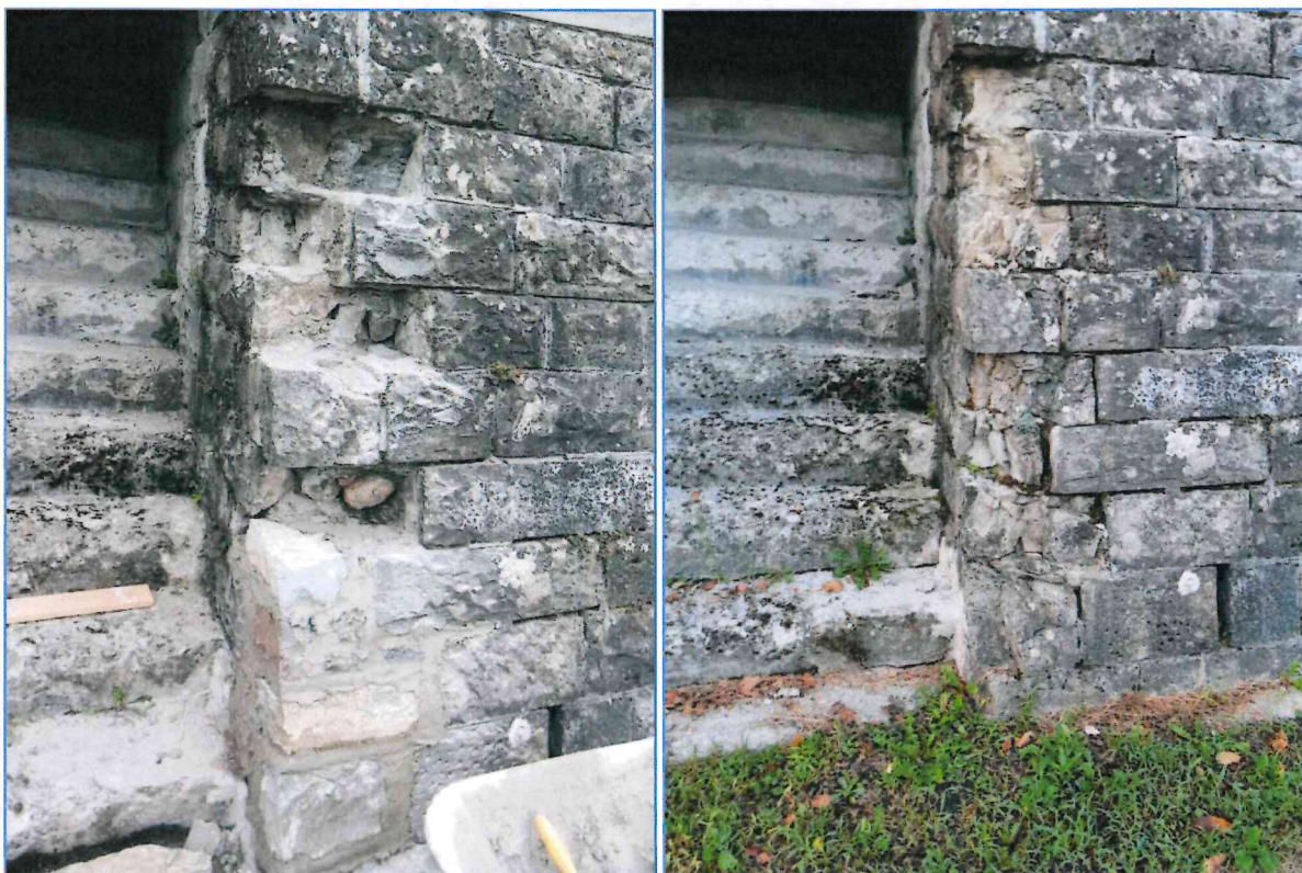
Foto 17 – Condizioni murette a lato dell'infrastruttura viaria prima della sistemazione
