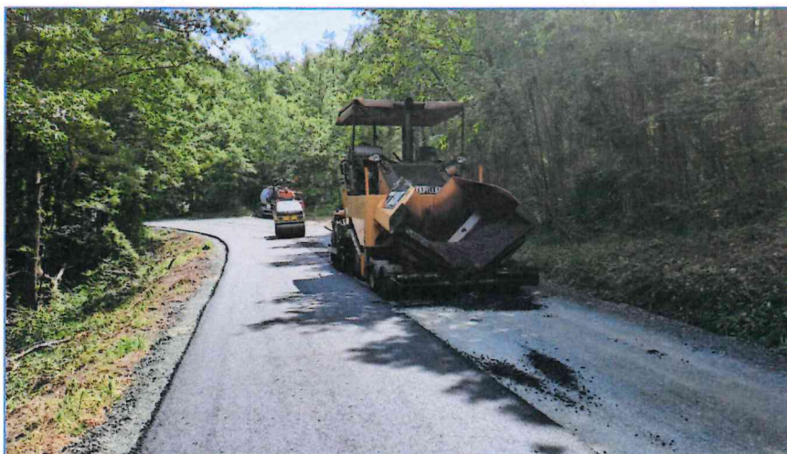
Foto 9 – Ripristino manto stradale con mezzi d'opera in azione
