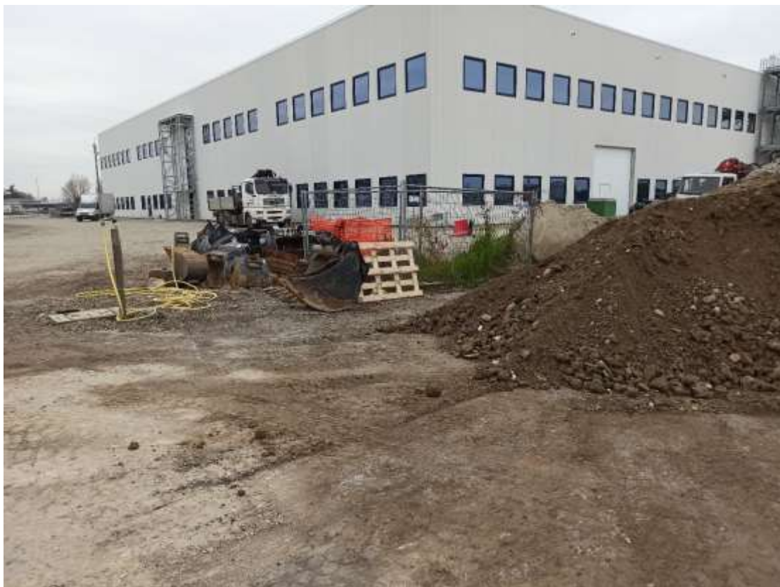
Figura 5: Zona di triturazione con evidenza della fornitura idrica per l'eventuale bagnatura dell'area
