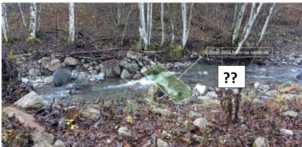
Figura 17: vista del tratto in cui verranno inserite le strutture di captazione. La presa verrà realizzata in corrispondenza di una struttura preesistente di regimentazione.
