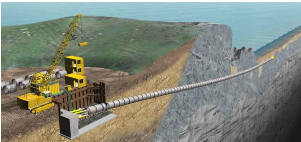
Figura 8-3 – Fase di scavo del microtunnel
