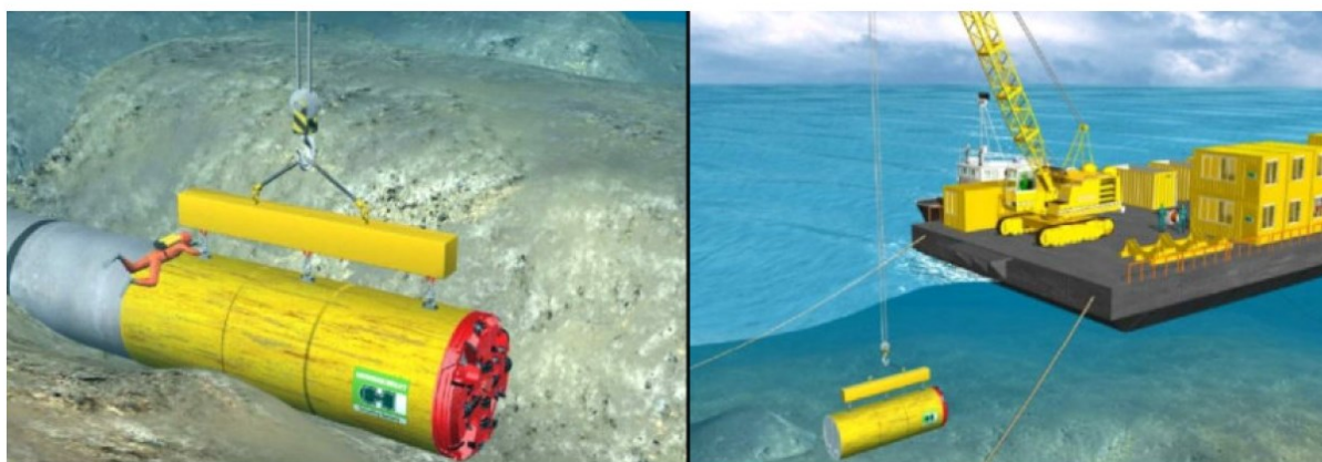
Figura 8-4 – Recupero della fresa meccanica a mare
