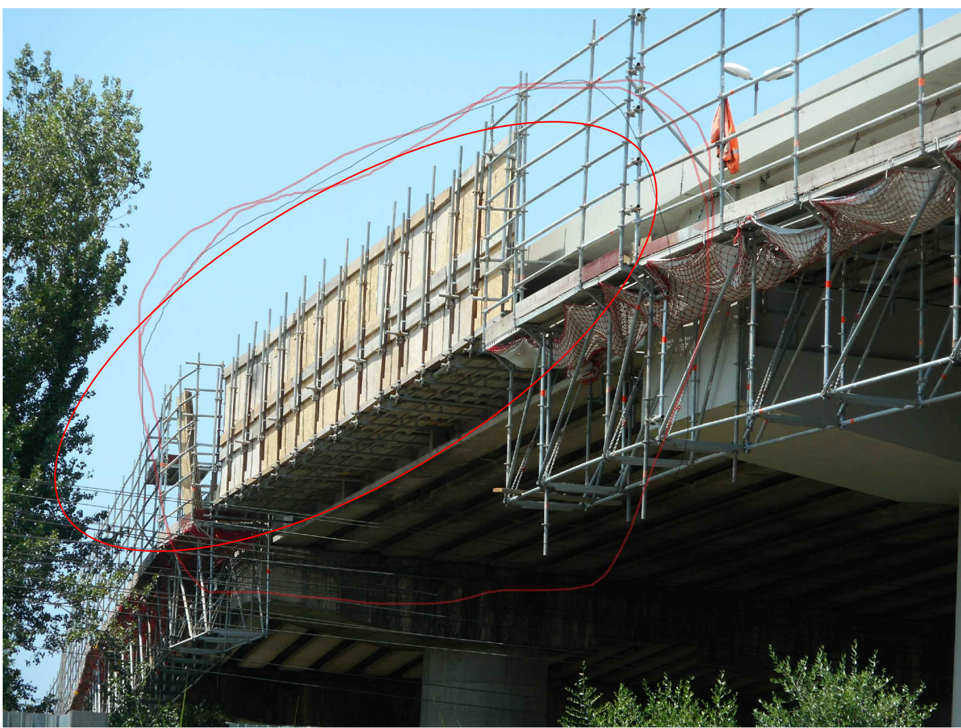
ponteggio sospeso con schermatura totale in pannelli di legno
