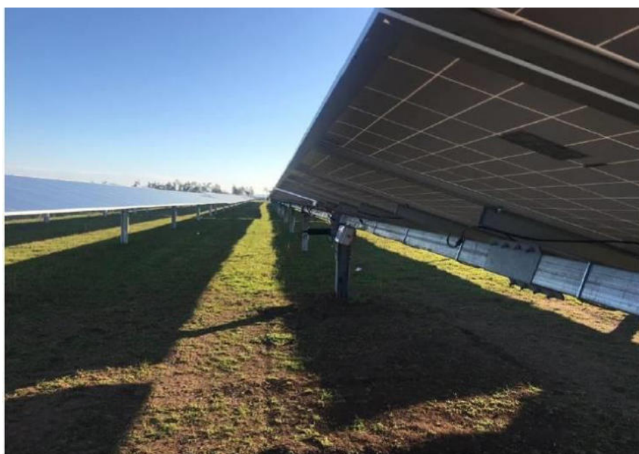
Figura 2.1.2 – Esempio di impianto fotovoltaico realizzato con supporti costituiti da pali in acciaio infissi direttamente nel terreno. Gli impatti sul suolo sottostante risultano essere minimizzati.
