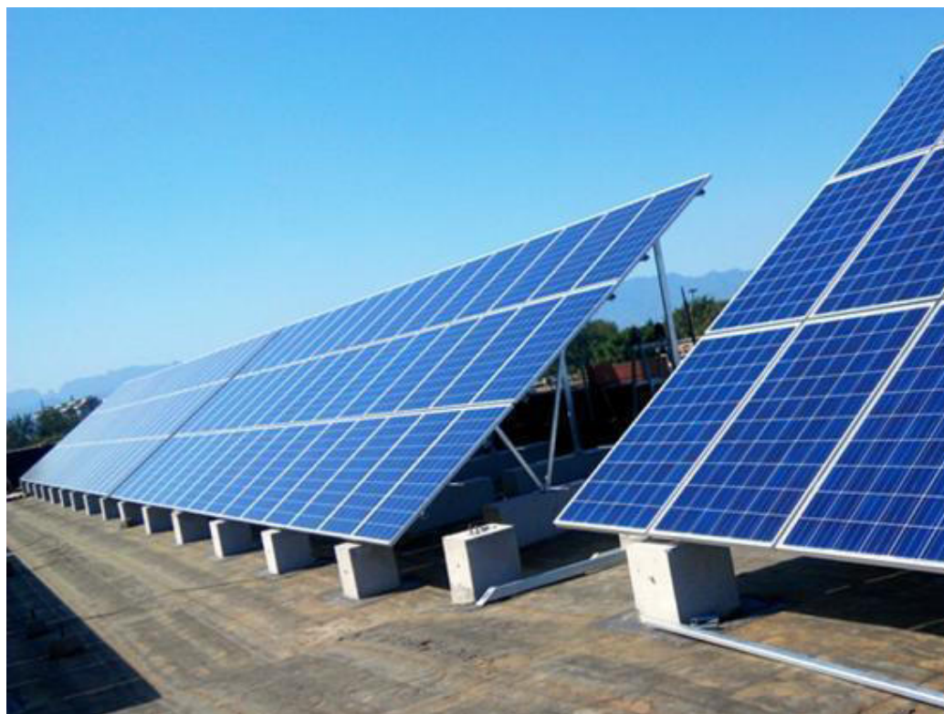
Figura 2.1.6 – Esempio di impianto fotovoltaico con fondazioni formate da zavorre costituite da plinti in cemento.
