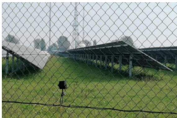
Figura 3.4.1 – Esempio di realizzazione di un impianto fotovoltaico senza fondazioni in cls e senza impermeabilizzazione del suolo (scelta progettuale analoga a quella adottata per l'impianto in esame).
