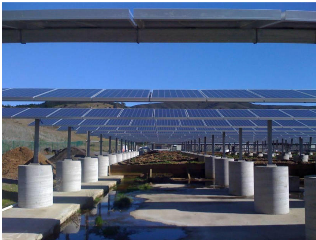
Figura 2.1.5 – Esempio di impianto fotovoltaico con fondazioni formate da zavorre costituite da plinti in cemento.
