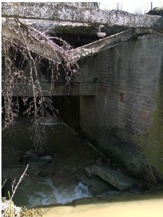
Foto n.1 – vista da monte ed all’imbocco del Cavo Baciocca sotto alla ferrovia meditante manufatto in precarie condizioni statiche.
