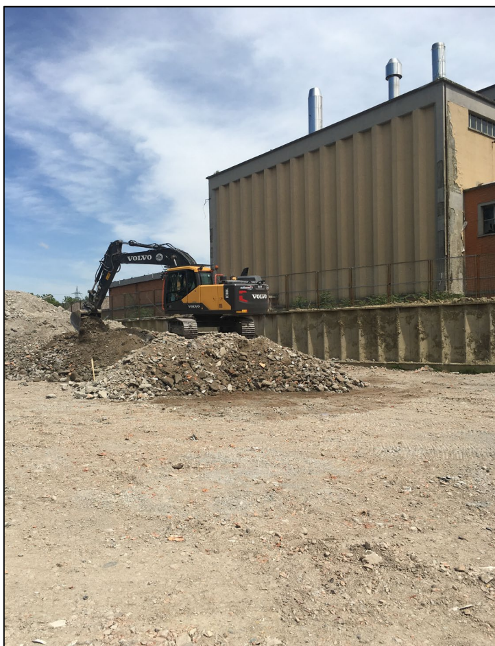
Foto 2 – Stato di fatto dell'area dove verranno svolte le attività di frantumazione e vagliatura con in corso lo stoccaggio in cumuli dei materiali derivanti dalle lavorazioni di demolizione delle strutture presenti nel Lotto che verranno trattati con impianto mobile.
