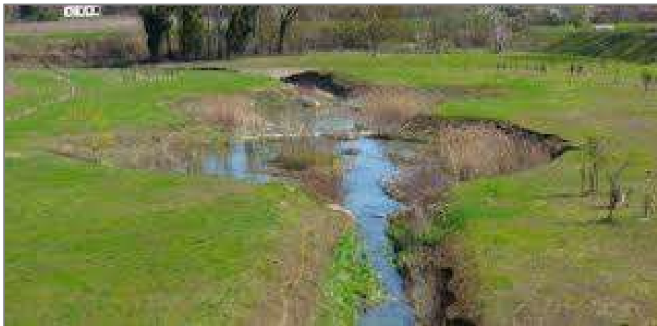
Figura 15 – Nuovo percorso del Rio Ronco in cui si è rimosso il rivestimento in calcestruzzo di fondo e delle sponde, si è meandrizato e lo si è dotato di ampie lanche che svolgono una funzioni ambientali di zona umida con valenze fitodepurative.
